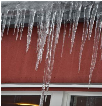
Bild 2. Omfattande istappsbildning är ett tecken på att alltför varmt yttertak. (Foto: Anneling Tobin Consult AB.)
